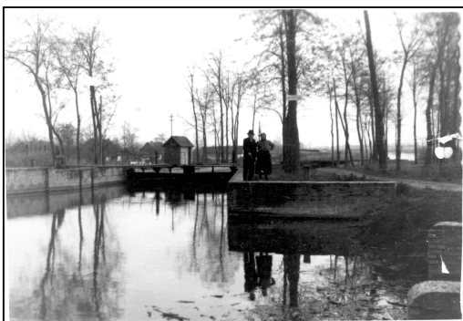
Керестурски шлайс, уход зоз висшого бегелю. На ліво простор дзе уходзела вода под млін и гнала колесо. Старши людзе на фотки непознати
